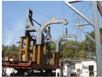
双吊点波浪补偿吊机在工作台上图片
